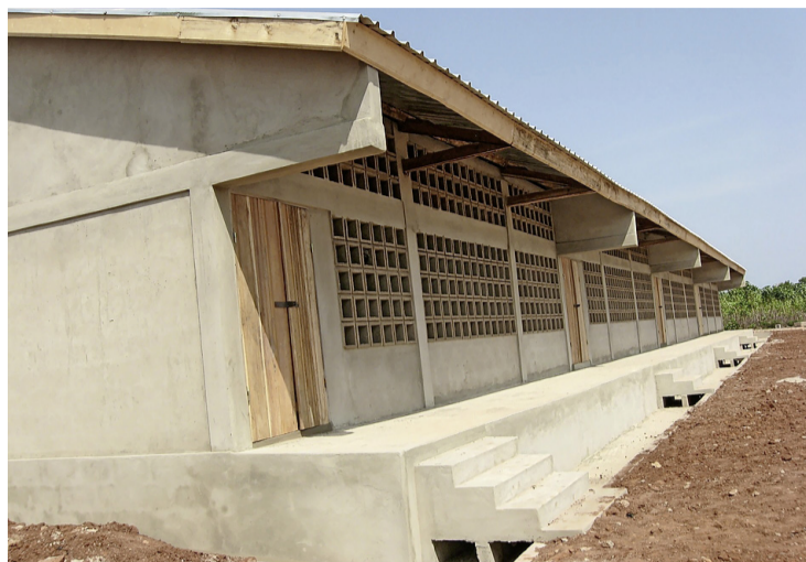
Prise de vue d'un chantier d'une de ces écoles. Association Assikloassi
