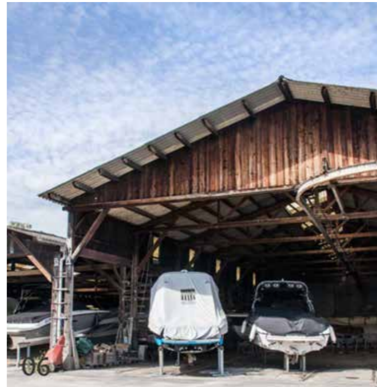
Chantier naval de Corsier - HAUTEUR HALLE 9 METRES
